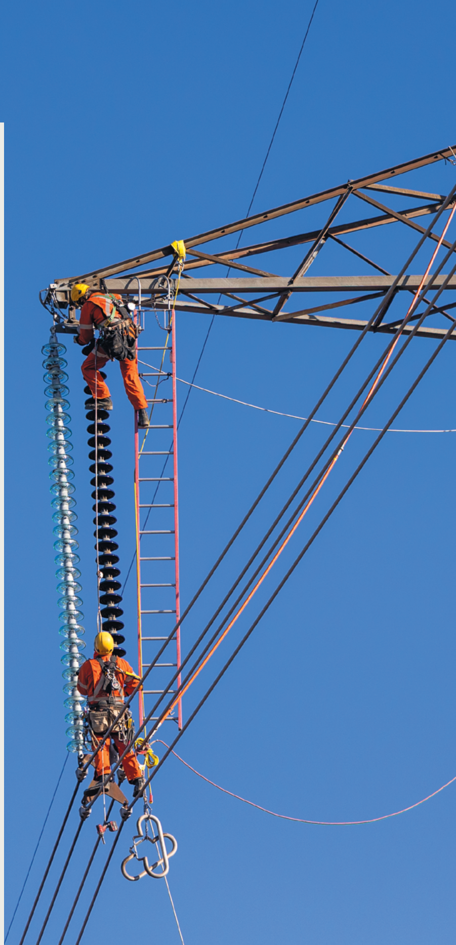
Travaux de maintenance : remplacement d'isolateurs
