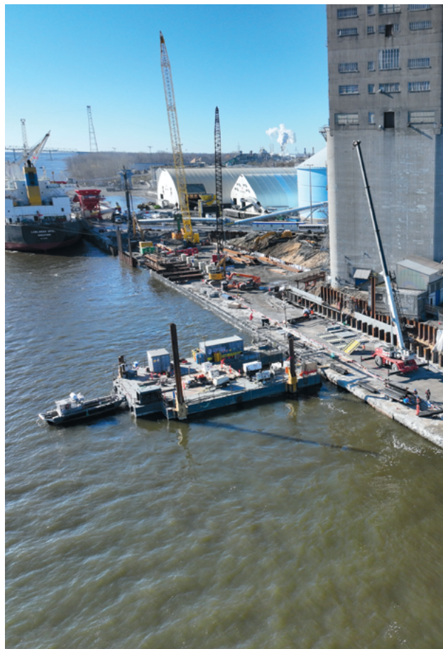
Le chantier de modernisation et de sécurisation des infrastructures portuaires de Trois-Rivières
