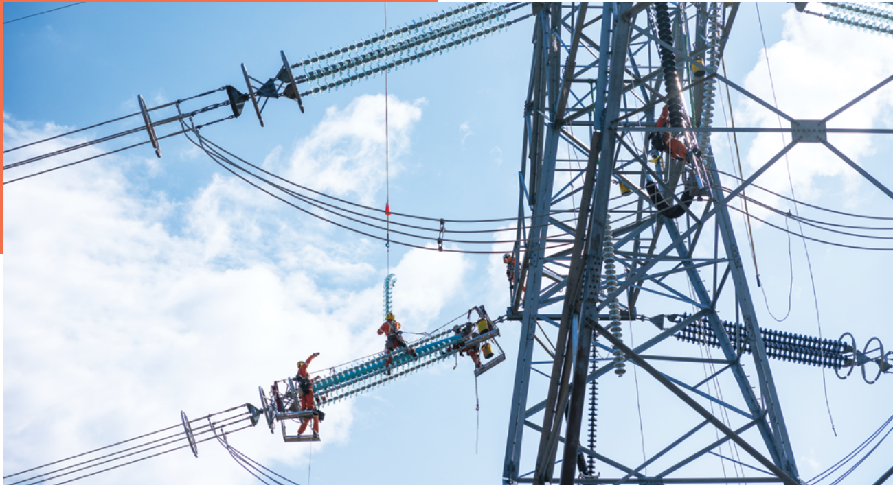
Travaux de maintenance : remplacement d'isolateurs
