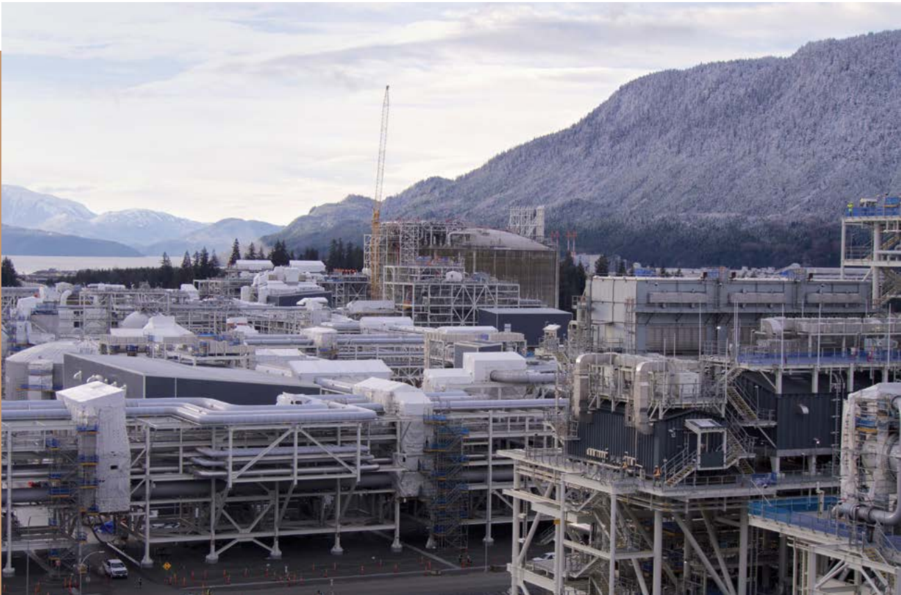
Installation de LNG Canada à Kitimat, en Colombie-Britannique, novembre 2024.
