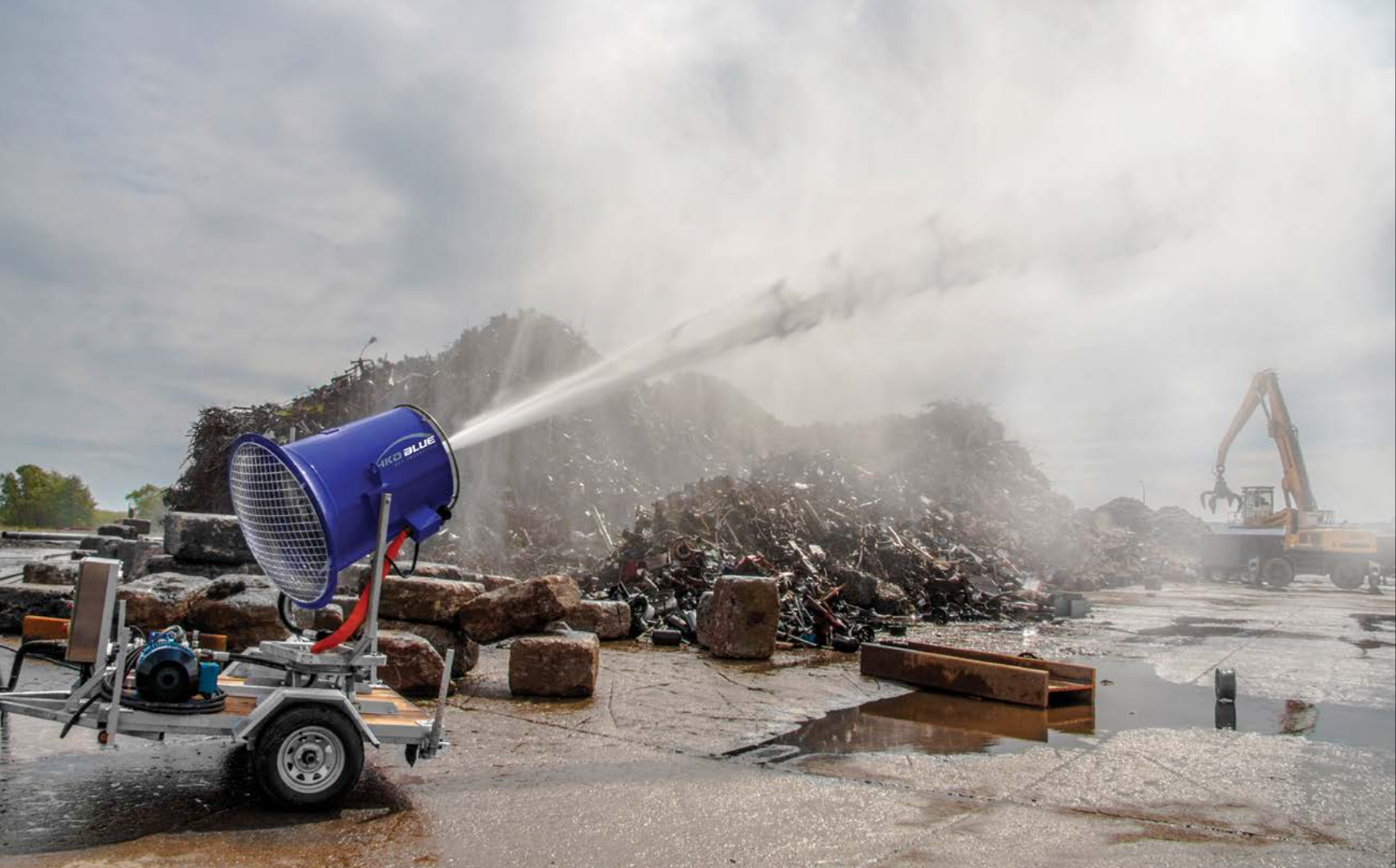
Des canons à neige adaptés permettent de gérer les poussières émises dans l'air sur les chantiers.
