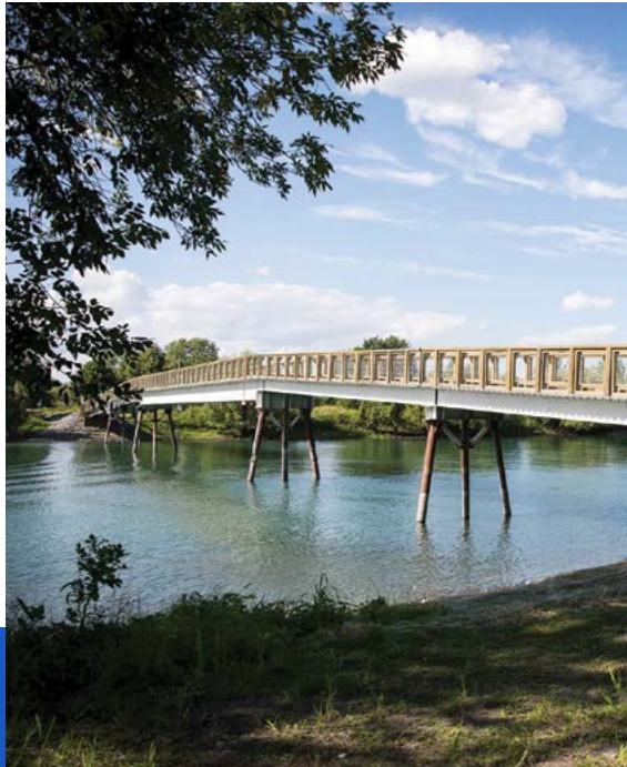
Passerelle avec tablier en aluminium développé par l'entreprise québécoise MAADI et installé au parc national des Îles-de-Boucherville.
