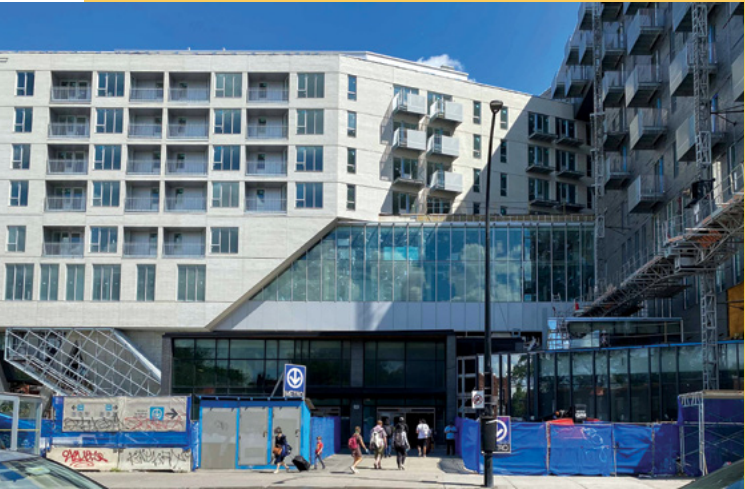
L’Îlot Rosemont, construit au-dessus de l’édicule de la station de métro Rosemont, à Montréal.
