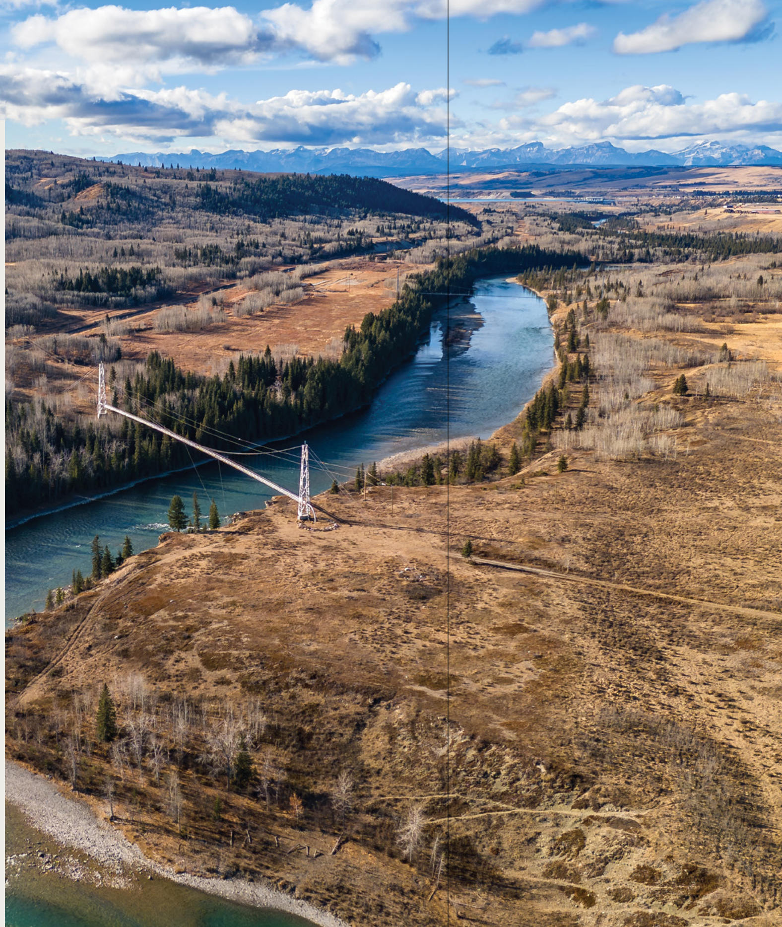
Pont de gazoduc traversant la rivière Bow, en Alberta.
