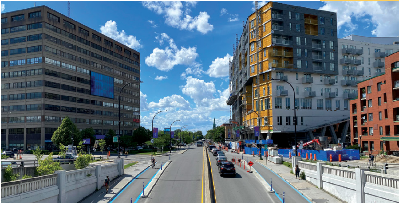
L’Îlot Rosemont, à Montréal, vu de la rue Saint-Denis.
