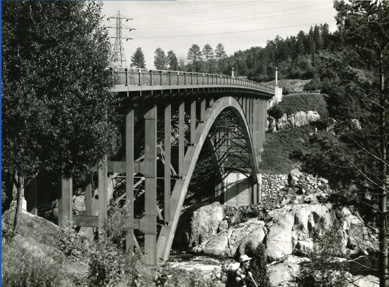
Le premier pont en aluminium au monde a été construit à Arvida en 1950.
