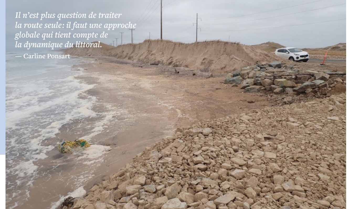
En novembre 2018, une tempête a causé un recul important de la dune de près de 15 m dans le secteur de la route 199, aux Îles-de-la-Madeleine. Des petits enrochements ont été faits en urgence en décembre 2018 pour protéger une section de la route.
