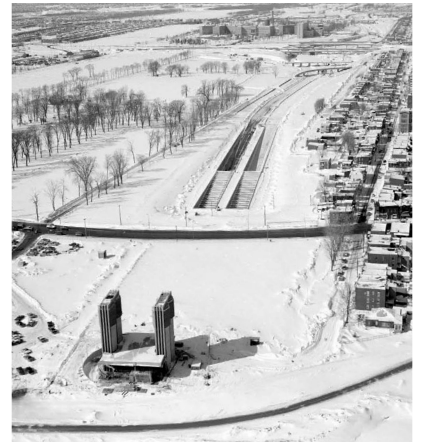
Construction du pont-tunnel Louis-Hippolyte-La Fontaine en 1967
