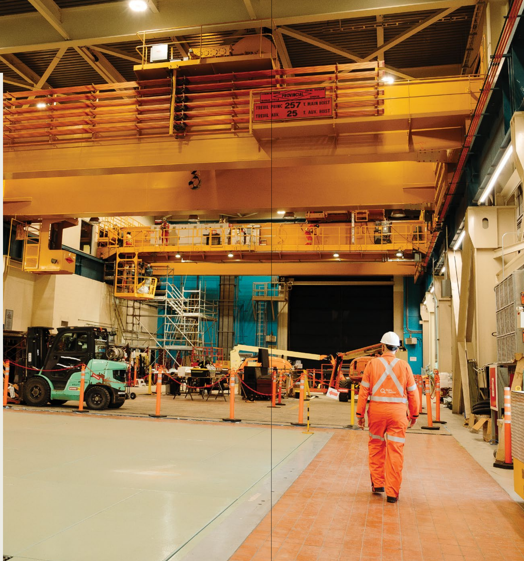
Réfection des ponts roulants à la centrale aux Outardes-2
