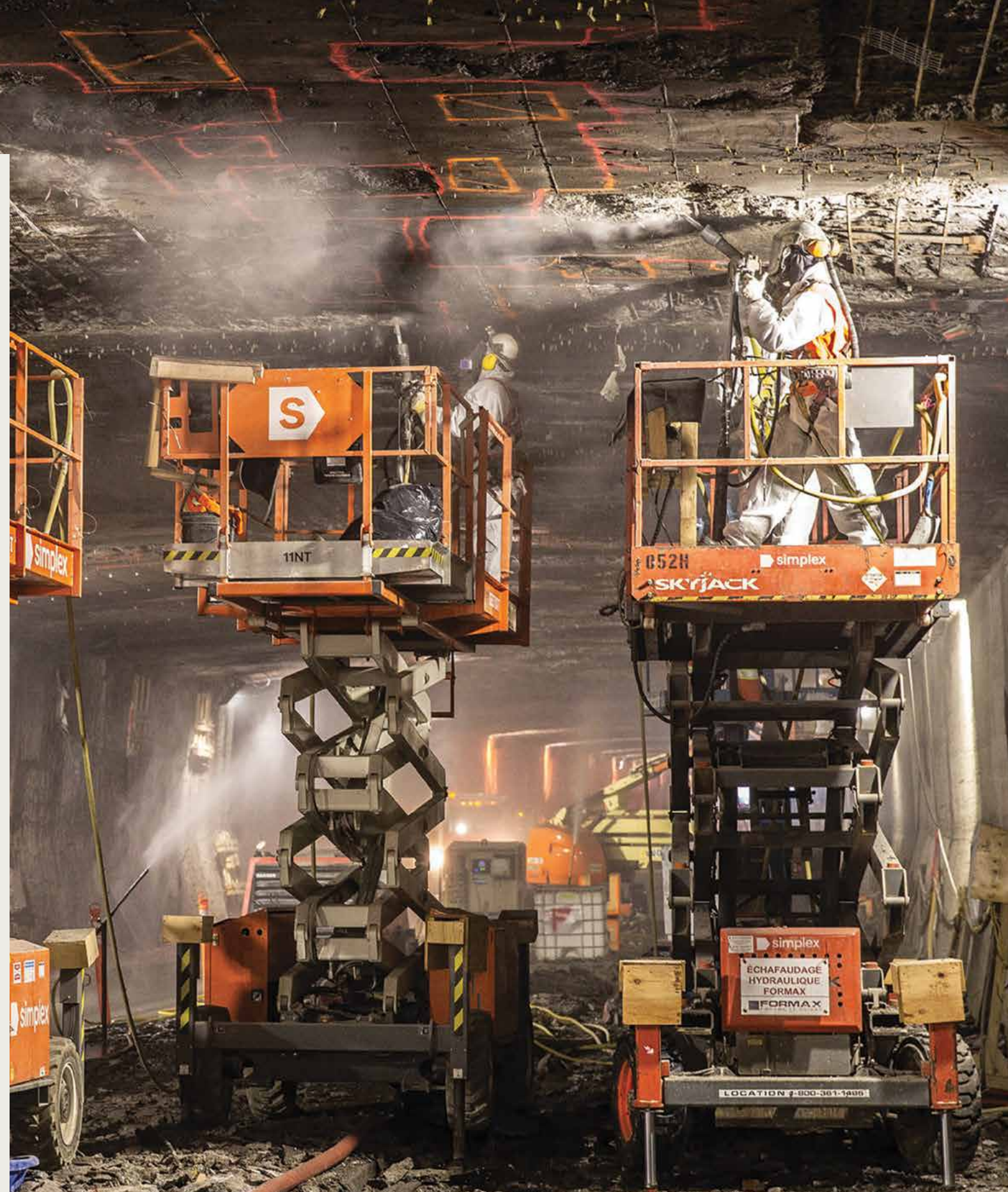
Réfection majeure du pont-tunnel Louis-Hippolyte-La Fontaine
