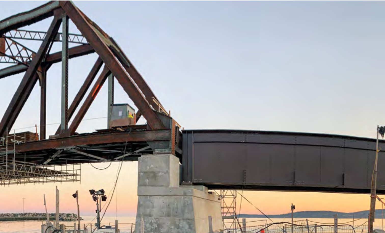
LE PRIX GÉNIE-VOIRIE EN DÉVELOPPEMENT DURABLE VA À CRT CONSTRUCTION. RÉFECTION DU PONT FERROVIAIRE ENJAMBANT LA RIVIÈRE À SAUMONS PORT-DANIEL EN GASPÉSIE. CR: CRT CONSTRUCTION
