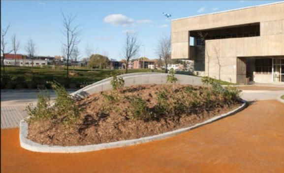
Colclair® est la gamme des revêtements clairs et colorés de Colas fabriqués à partir du liant de synthèse Bituclair® à chaud, tièdes ou à froid.
