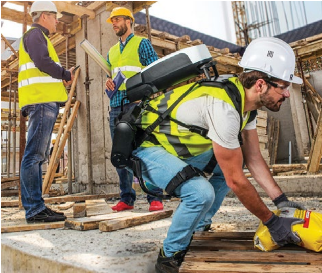
L'EXOBACK. UN AUTRE TYPE D'EXOSQUELETTE EST DÉVELOPPÉ PAR RB3D, UN OUTIL ACTIF D'ASSISTANCE LOMBAIRE POUVANT ÊTRE UTILE SUR LES CHANTIERS DE CONSTRUCTION. SA HANCHE À DOUBLE ARTICULATION PERMET DE RÉDUIRE LES EFFORTS DE L'OPÉRATEUR ET LES TROUBLES MUSCULO-SQUELETTIQUES ASSOCIÉS À LA MANUTENTION. CR: GROUPE COLAS (2019)
