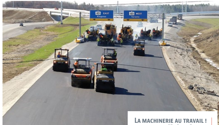
LA MACHINERIE AU TRAVAIL ! CR: COCO PAVING.
